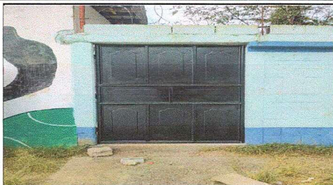
Foto 2: SUSTITUCIÓN DE PUERTA DE METAL POR DETERIORO.
