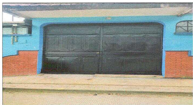
Foto 5: SUSTITUCIÓN DE PORTON POR DETERIORO.
