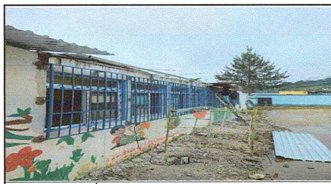
Foto 6: COLOCACIÓN DE NUEVOS BALCONES PARA CUBRIR LAS VENTANAS PVC.
